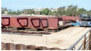
Les travaux d'assemblages réalisés actuellement le long de la passerelle piétonne côté SOR sont les travaux de fabrication des pontons de remplacement des travées situées au-dessus du fleuve. Ces pontons seront au nombre de 4 avec pour dimensions : L 30 m / l 12 m / H 2 m
